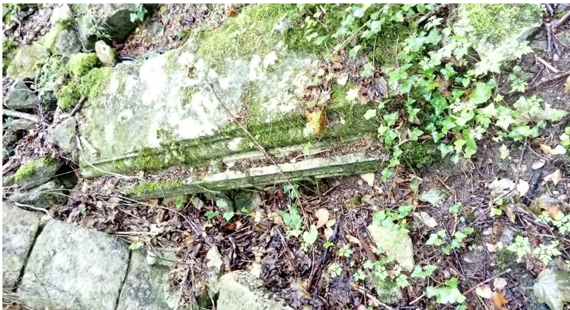
Figure 35 : Corniche du mur B, au sol, photo Bérénice Rondot, 2017
