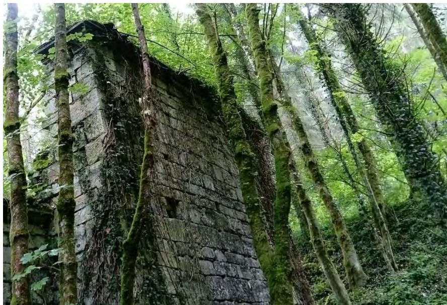
Figure 33 : Parement extérieur, mur B, photos Bérénice Rondot 2017.
