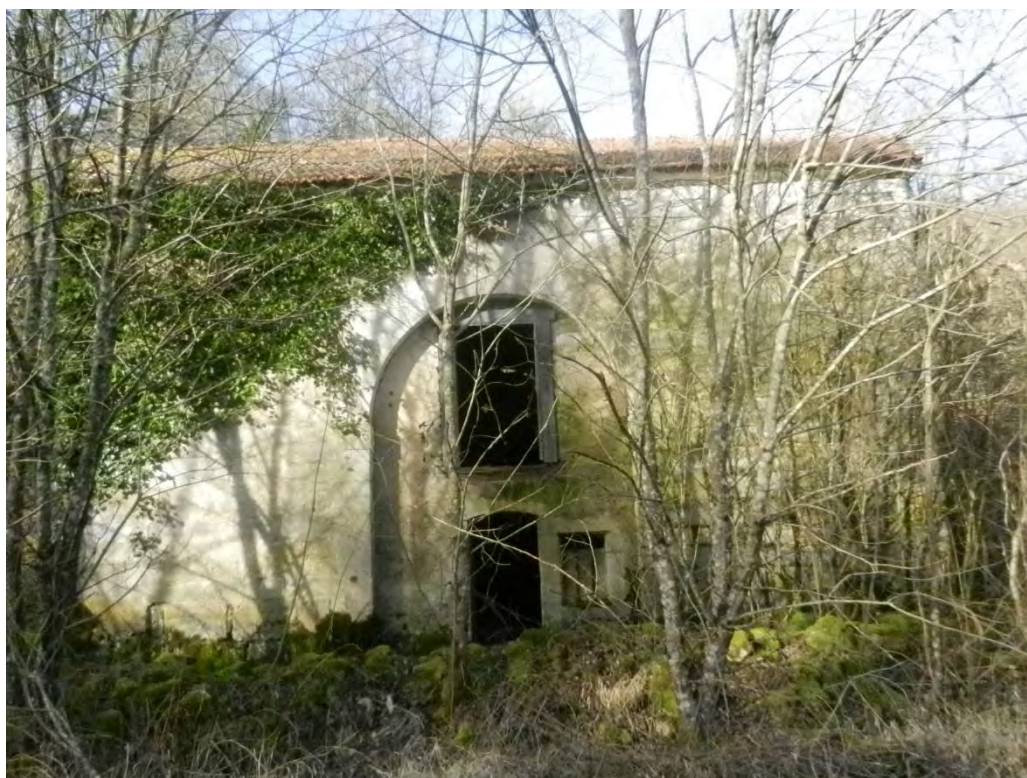
Figure 12 : La ferme en 2014, un an avant sa démolition. Source Jean-Michel LANGARD, 2014
