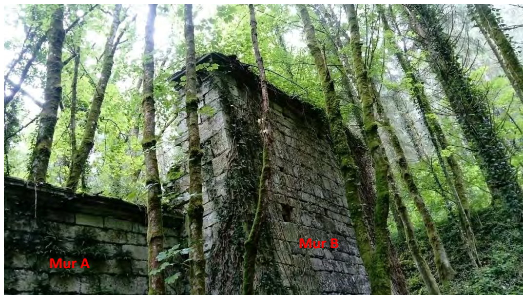
Figure 27 : Les murs A et B, photo Bérénice Rondot, 2017.
