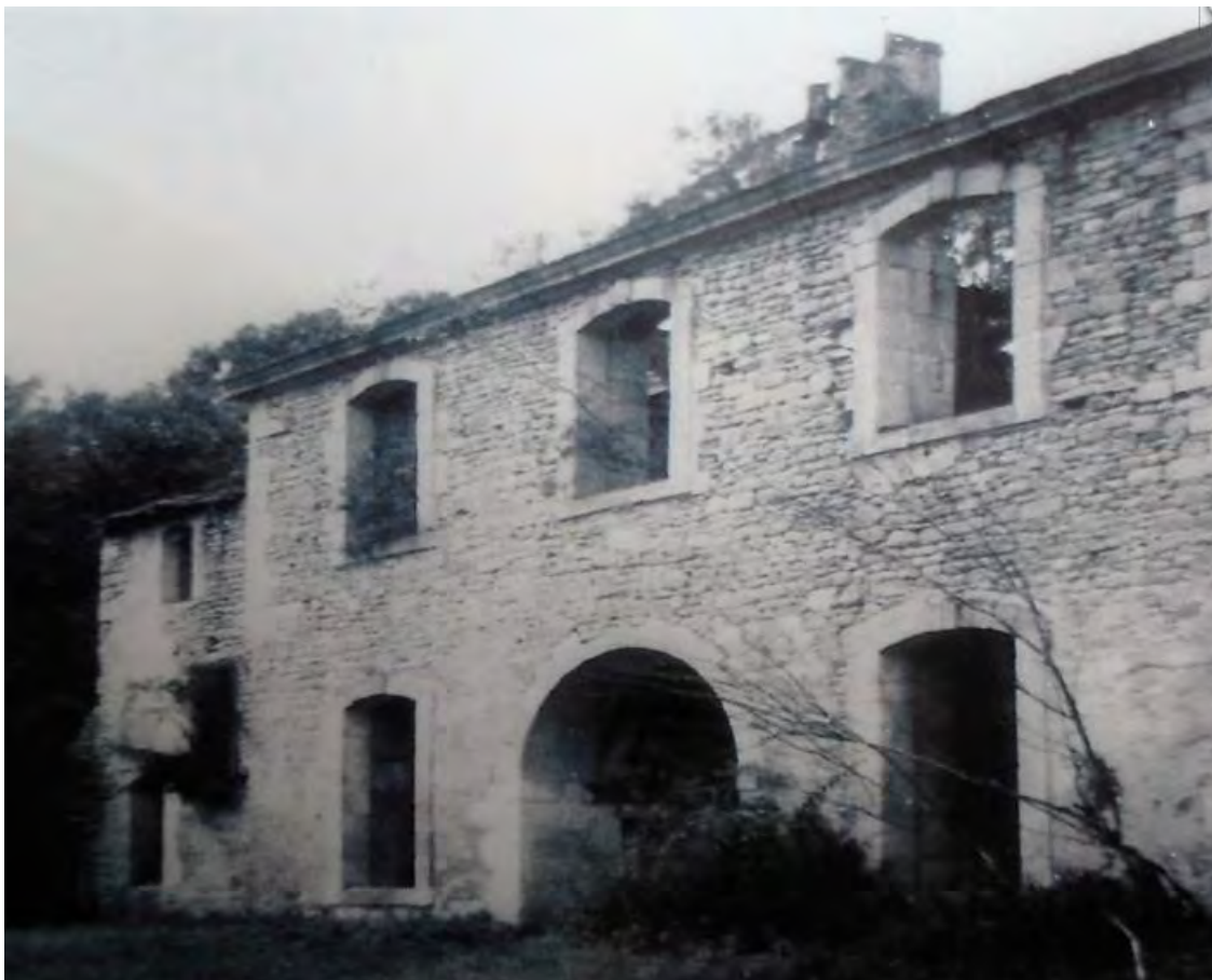
Figure 9 : La Porterie après l'incendie, documents de l'association « Pargny Vie et Patrimoine ».
